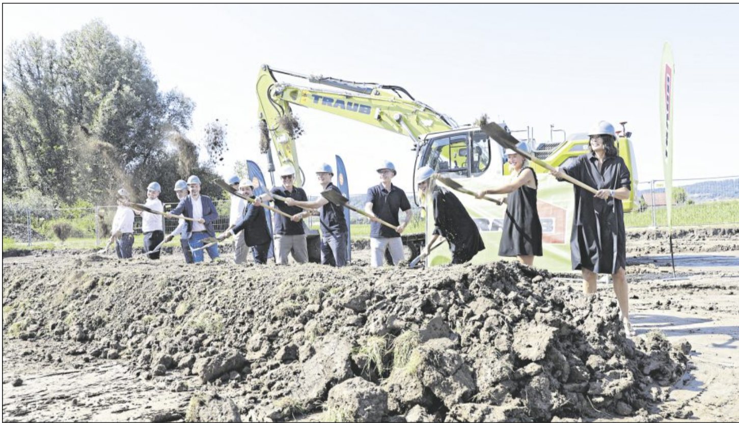
Mit einem symbolischen Spatenstich wurden die Arbeiten zum Neubau in Michelau gefeiert.
