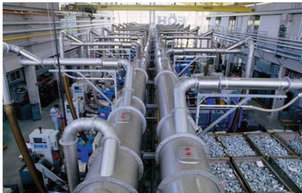
Bild 2: Emissionen werden direkt an den Maschinen und Öfen erfasst.
